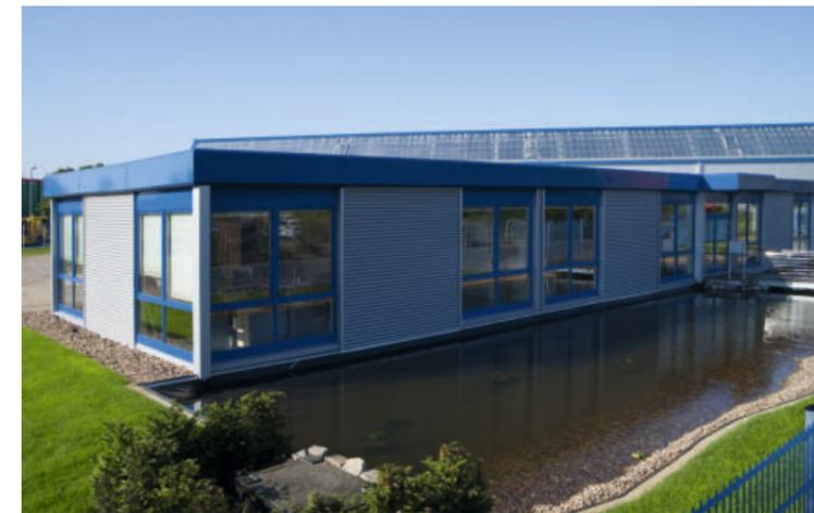
Das modulare System von Losberger De Boer bietet dem Bauherrn den Vorteil, zunächst nur in die zum Zeitpunkt des Baus benötigte Bürofläche zu investieren. Sollte eine Erweiterung notwendig werden, kann diese ohne Bauschmutz und -lärm ausgeführt werden, z. B. durch das Ansetzen von Modulen oder durch eine Aufstockung des Gebäudes.
