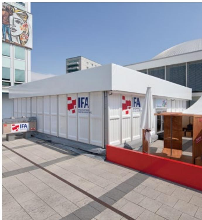
Anclaje al suelo: anclaje de acero, longitud máx. de la tienda: eje longitudinal de la sala, carga de nieve: ninguna (posible bajo petición), carga de viento según EN13782, medidas claras desde el borde superior del piso. Una altura lateral de 3,40 m está disponible en el programa de ventas.
